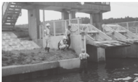
▲排水樋門点検の様子
