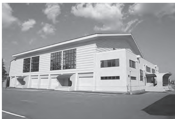
改修工事が完了した町民体育館
