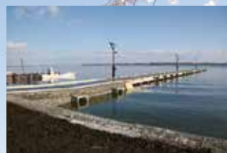
船ヶ沢分場漁業用栈橋完成
