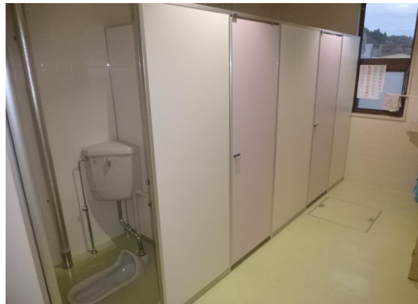
⑱女子便所（改修後）
