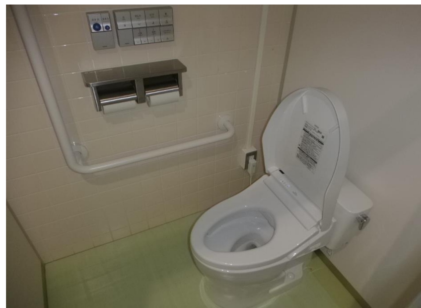
⑳女子便所便器（改修後）
