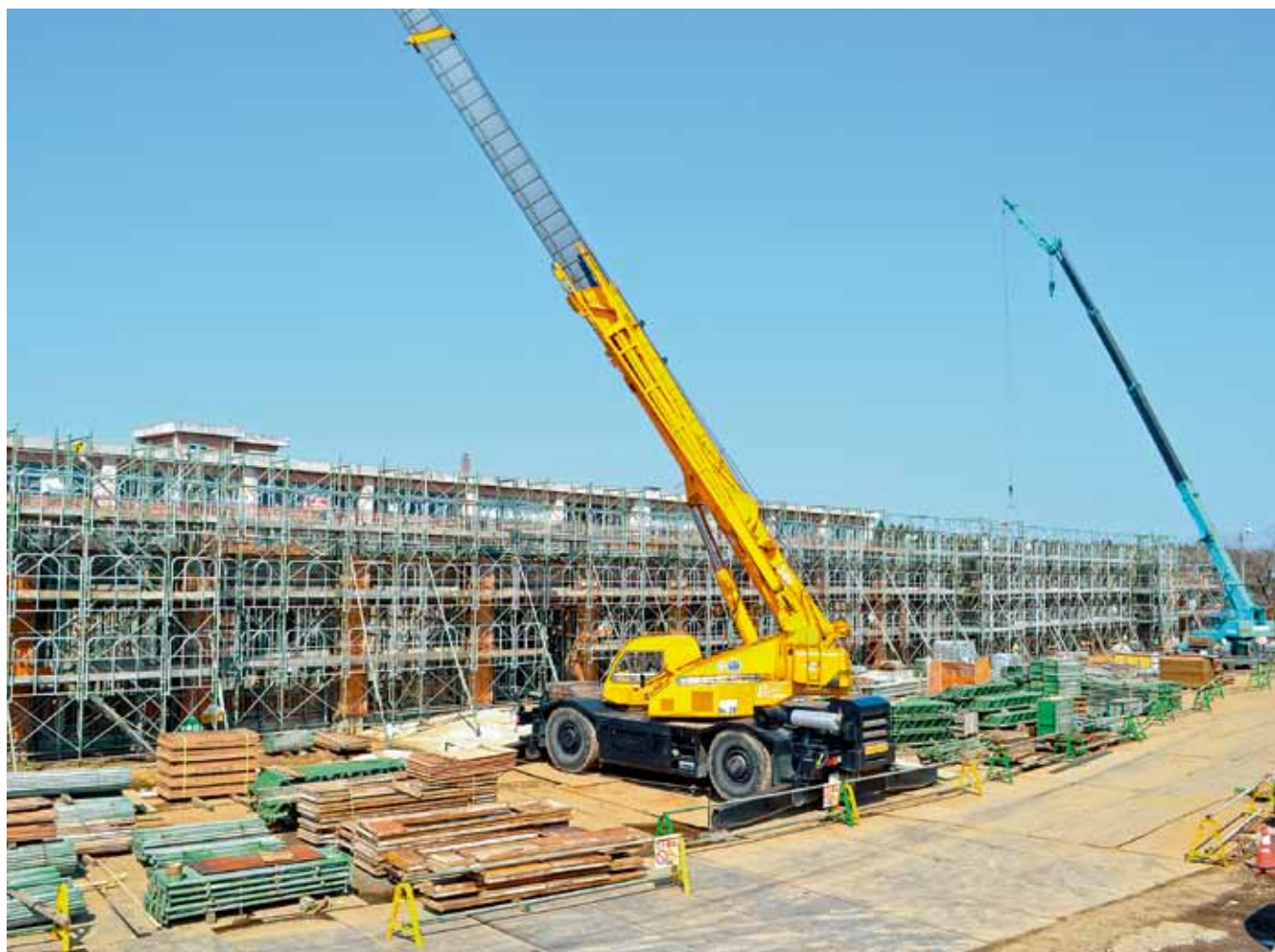
順調に進む東北中学校校舎改築工事
