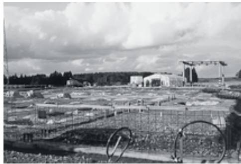
ながいも洗淨選別・貯蔵施設工事現場
