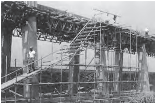
沼崎本村付近にて鉄道高架橋の建設 [昭和42年]
