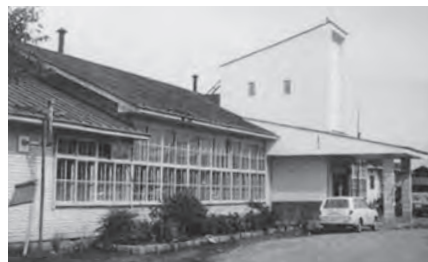
新築された旧上北町役場庁舎 [昭和33年]
