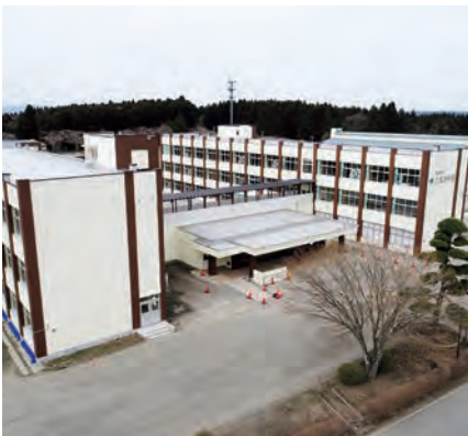
上北小学校校舎改修工事完了 [令和 2年]
