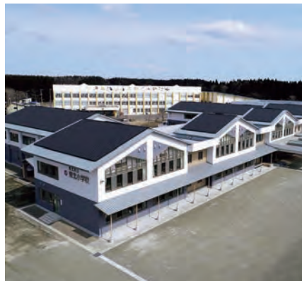
東北小学校新校舎完成 [平成 31年]
