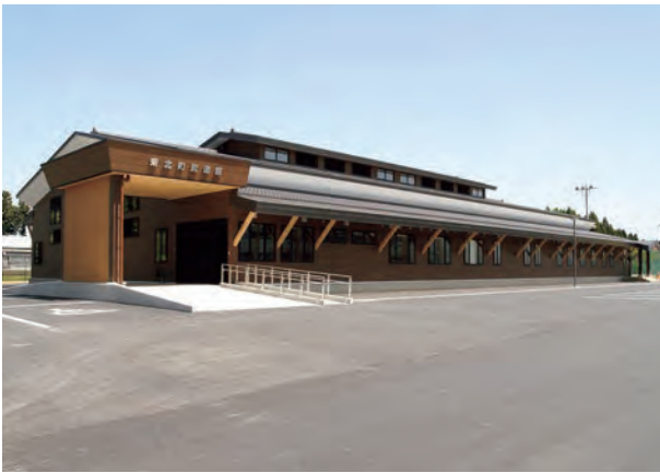
「東北町武道館」完成 [平成 29年]
