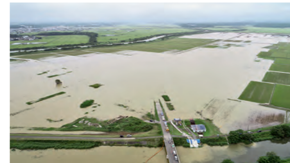
排水作業中の間手場周辺（8月16日）
