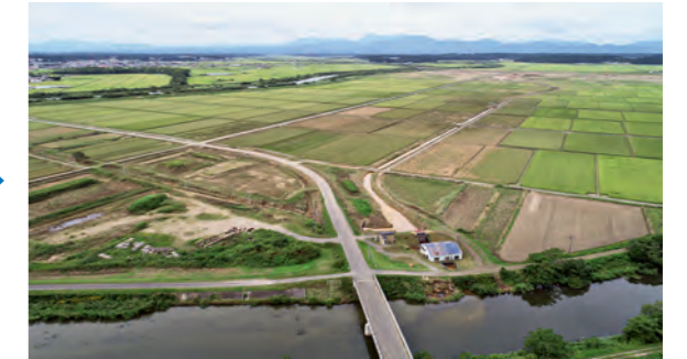
排水作業終了後の間手場周辺（9月1日）
