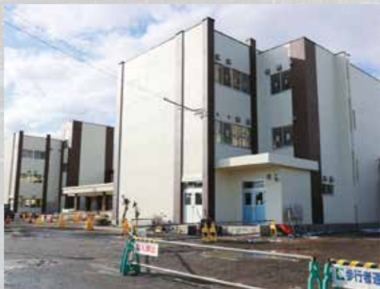
改修工事が進む上北小学校の校舎
