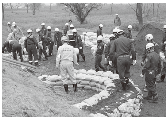
災害時に役立つ工法を習いました
