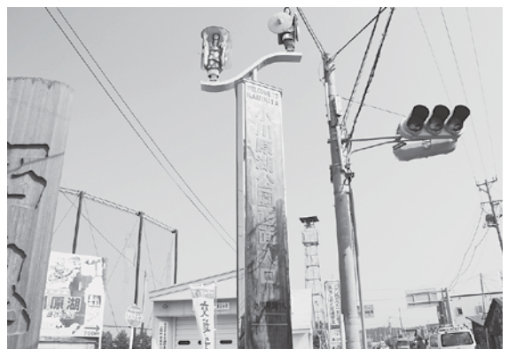
塗装工事を終えた町観光案内看板
