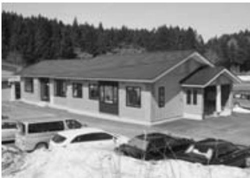
完成した淋代地区生涯学習センター
