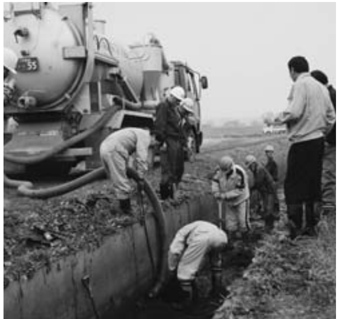
バキュームカーも出動して泥を吸い上げました
