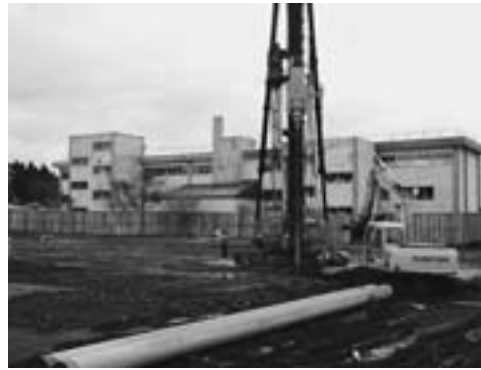
改築工事が進む現場。奥は現校舎
