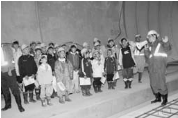
トンネル工事について説明を受ける児童
