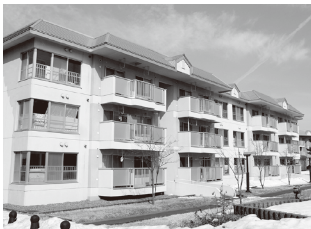
町営住宅・丘ノ上団地
