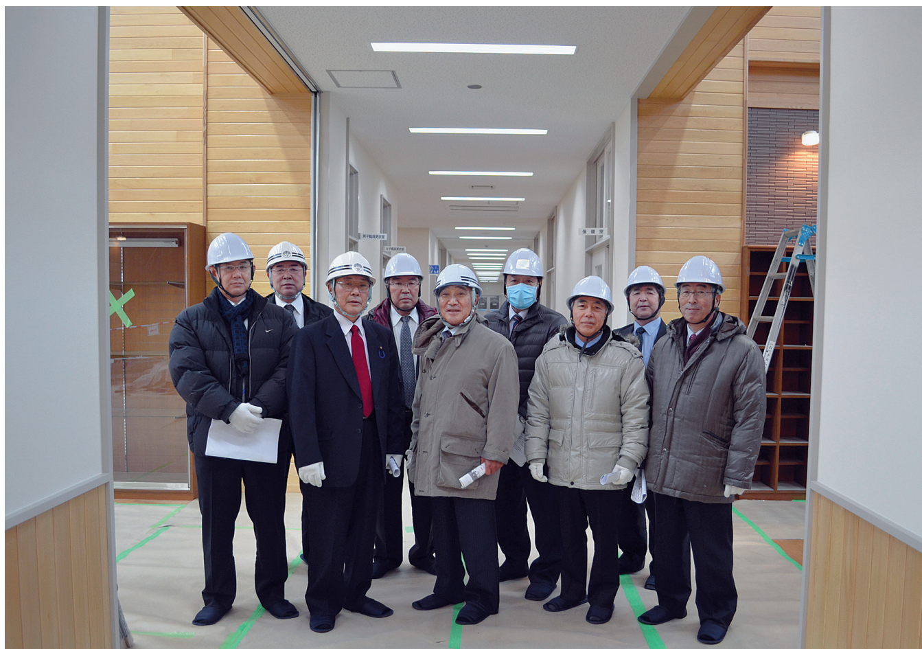
東北中学校校舎改築工事の進捗状況視察 (平成26年12月11日 教育民生常任委員会)
